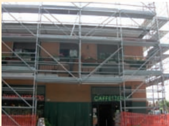
Esempi di ponteggi da cantiere dove si è adottata la tecnica di alternare i montanti che vengono interrotti, determinando pertanto al piano terra un passo di 360 cm.
