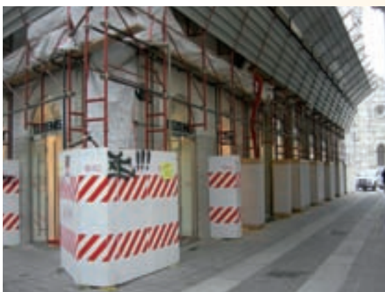
Esempi di ponteggi da cantiere dove si è adottata la tecnica di alternare i montanti che vengono interrotti, determinando pertanto al piano terra un passo di 360 cm.
