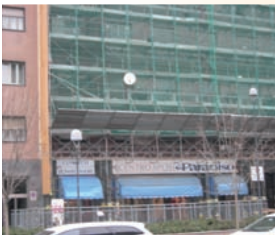
Esempi di ponteggio con piano terra adattato all'attività commerciale mediante impiego di apposite travi reticolari metalliche prefabbricate.
