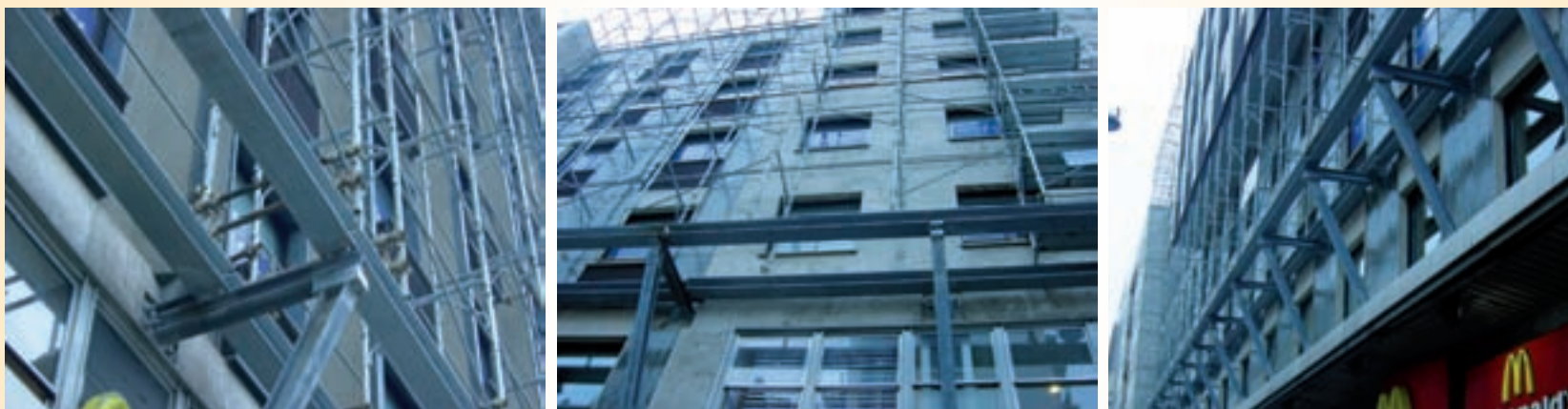
Esempio di ponteggio sospeso all'edificio che non possiede alcun montante al piano terra e lascia completamente libera al transito e alla vista l'area commerciale.
