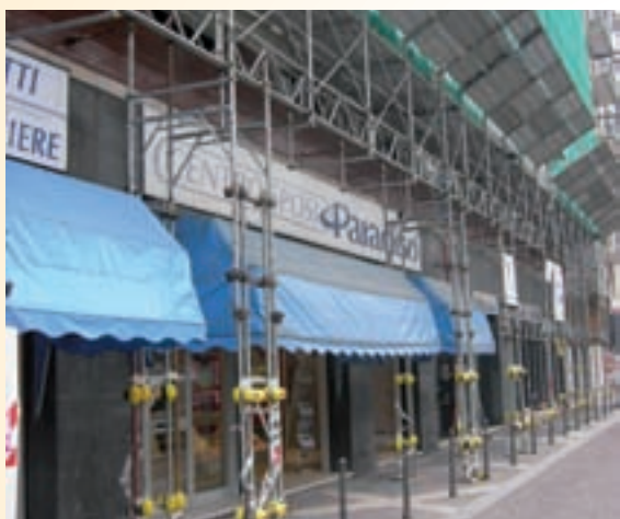
Esempi di ponteggio con piano terra adattato all'attività commerciale mediante impiego di apposite travi reticolari metalliche prefabbricate.
