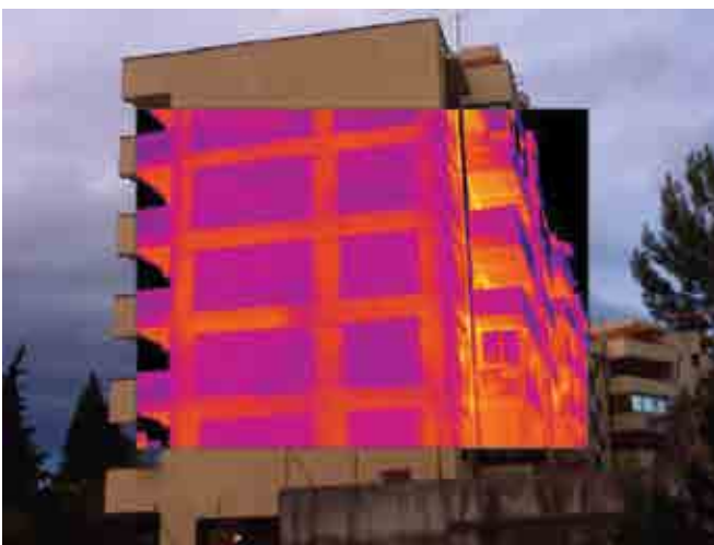
Termografia realizzata alle 6:00 temperatura esterna 20°C
