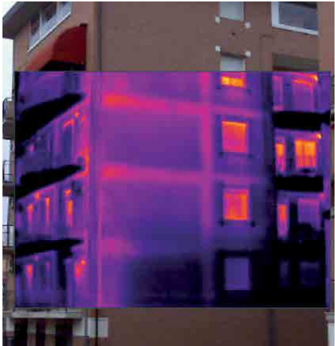
BOLOGNA - VIA DOSSETTI ANNO 2002 DISPERSIONI DELLE STRUTTURE IN CEMENTO ARMATO E CALORIFERI >>
