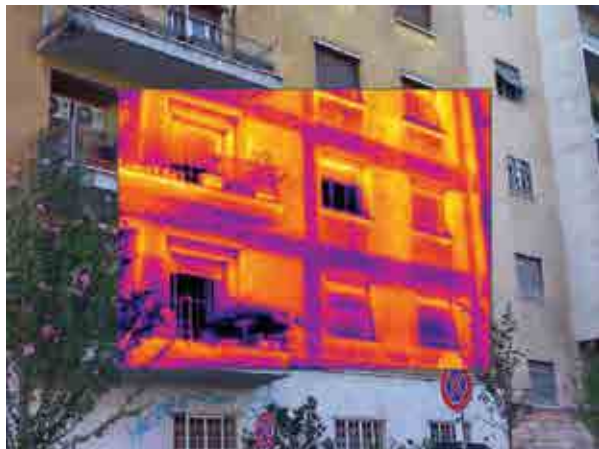
Termografia realizzata alle 14:00 temperatura esterna 35°C
