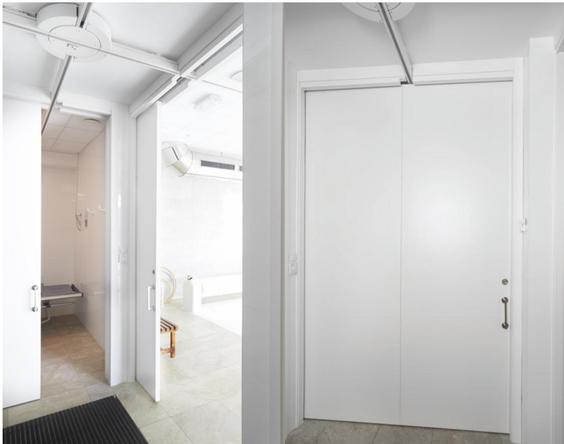
Hoist rappresenta una soluzione che permette di annullare le barriere architettoniche e beneficiare di tutti i vantaggi offerti dalla scelta di una porta scorrevole.
