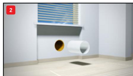
**2)** Inserire un tubo in PVC leggero, di quelli comunemente usati per realizzare le aperture di ventilazione (dis. 2).
