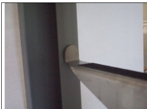
Posizione del montante rispetto allo scalino
