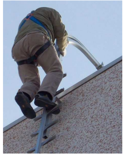
Zona di sbarco e trasferimento laterale
