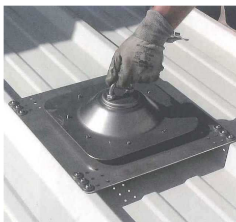
Fig. 13: posa in opera dell'ancoraggio
