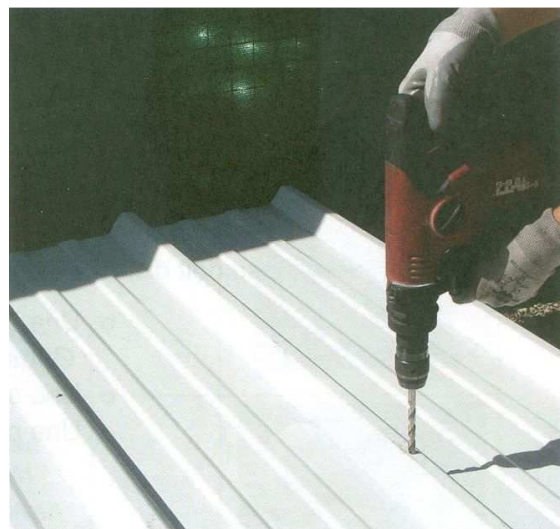
Figura 3: alesatura con foro da 9 mm
