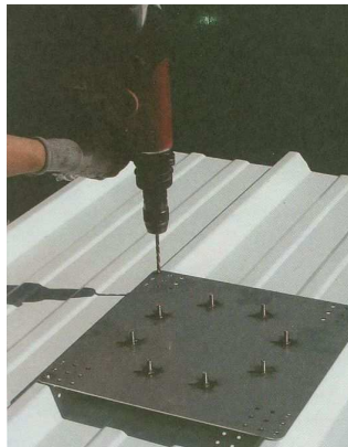
Fig. 7: preforatura
