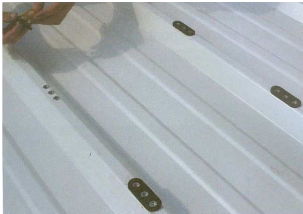
Fig. 9: incollaggio guarnizioni per inserti
