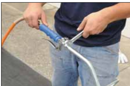
2. Stringere il dado del dispositivo saldagiunte con la chiave da 22 mm.
