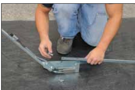
2. Agganciare il rullo pressagiunte con manico laterale al dispositivo saldagiunte fissandolo con bullone e dado a farfalla
