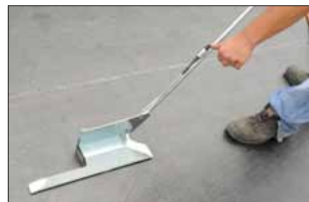
3. Accendere il cannello saldagiunte premendo il pulsante dell'accensione piezoelettrica
