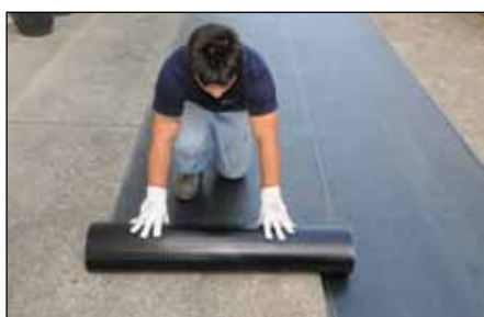
1. Srotolare il secondo rotolo di membrana bituminosa, sovrapponendolo al primo di circa 10-12 cm.
