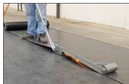
3. Dopo aver provveduto all'accensione del cannello, infilare la ciabatta saldagiunte al di sotto della seconda membrana, sfiammando e tirando verso se stessi
