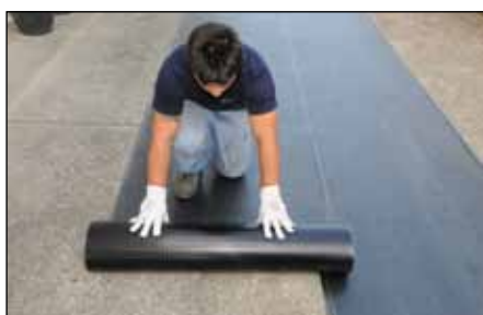
1. Srotolare il secondo rotolo di membrana bituminosa, sovrapponendolo al primo di circa 10-12 cm.
