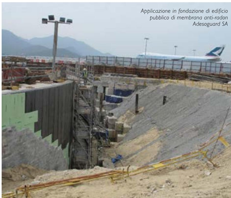
Applicazione in fondazione di edificio pubblico di membrana anti-radon Adesoguard SA
