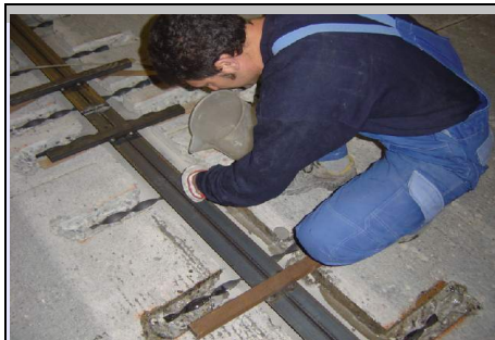
Sigillatura di un giunto metallico tipo Tm.
