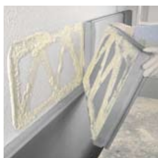
Dopo che la lastra è stata premuta contro il muro, il collante deve coprire almeno il 40% dell'intera superficie (considerando sia la schiuma sul supporto, sia quella sulla lastra).
