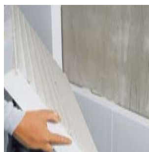
Dopo che la lastra è stata premuta contro il muro, il collante deve ricoprire almeno il 40% dell'intera
