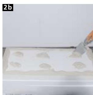
Dopo che la lastra è stata premuta contro il muro, il collante deve ricoprire almeno il 40% dell'intera
