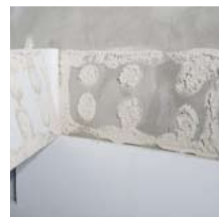
Dopo che la lastra è stata premuta contro il muro, il collante deve coprire almeno il 40% dell'intera superficie (considerando sia il materiale sul supporto, sia quello sulla lastra).
