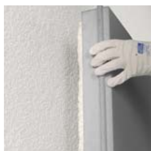
Disporre le lastre isolanti dal basso verso l'alto a giunti sfalsati (a partire dagli angoli dell'edificio) accostando al massimo le lastre tra loro. N.B.: Le lastre isolanti non vanno fatte aderire al muro battendole.
