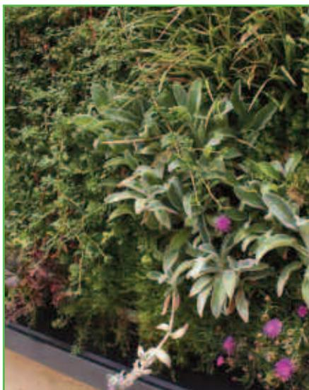
Questi interventi sono destinati alla realizzazione di paratie autoportanti o al rivestimento di murature già esistenti con inverdimenti mono e bifacciali, creando veri e propri giardini verticali, che generano effetti di compensazione, mitigazione e miglioramento dell'edificio stesso e del contesto ambientale circostante. Le pareti verdi attutiscono inoltre il rumore del traffico, raccolgono le particelle di polvere e assorbono l'inquinamento.
