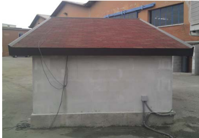
Figura 1 Cella di prova montante la copertura ventilata
