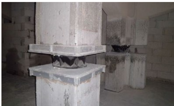
Figura 1: inserimento di isolatori e dissipatori
