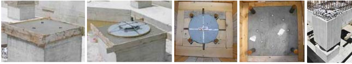
Immagine 30: Procedura d'installazione di isolatore friction pendulum su una nuova costruzione.
