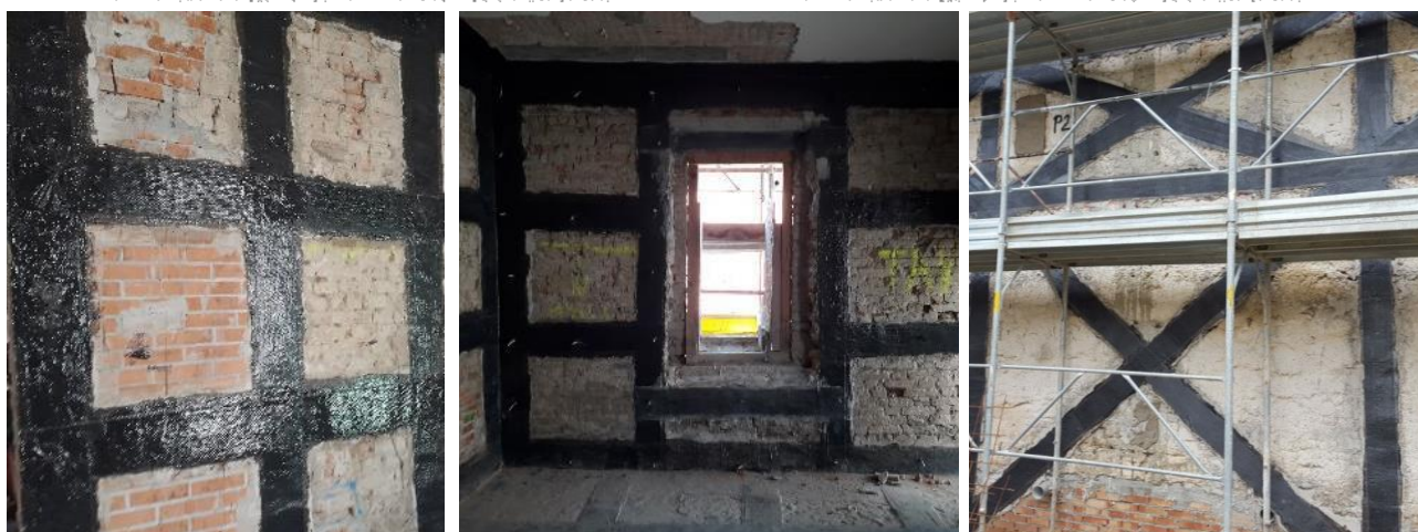
Immagine 15: Rinforzi murature con CFRP.
