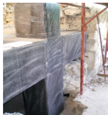
Immagine 4: Rinforzo nodi trave – colonna con CFRP.
