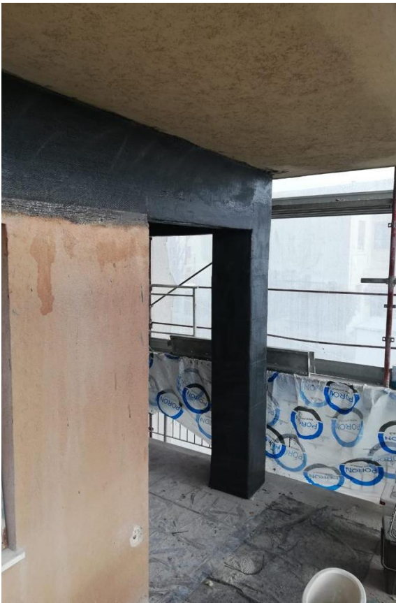
Immagine 1: Rinforzi strutturali con sistema FRP.
