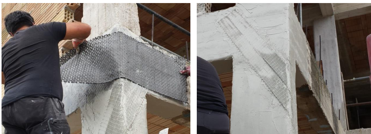
Immagine 5: Rinforzo nodi d'angolo con CFRP.
