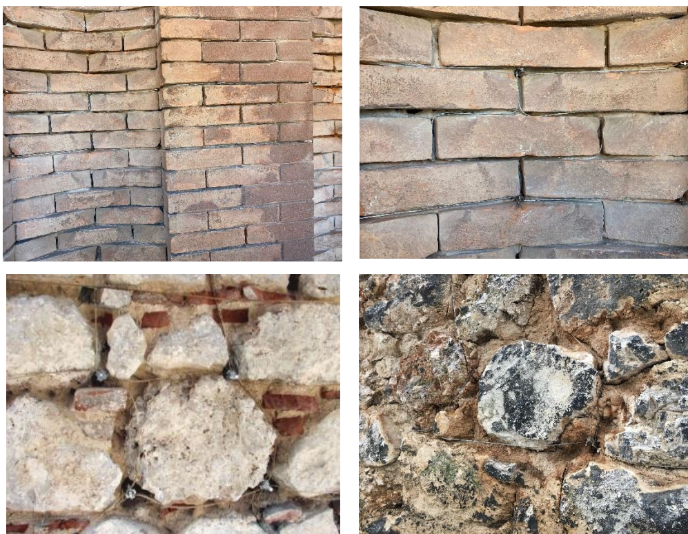
Immagine 23: Sistema ANCHORSTEEL NET su laterizio regolare e pietrame squadrato.
