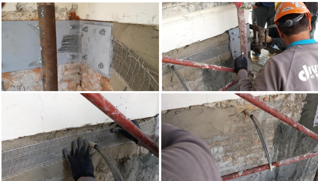
Immagine 19: Fasciatura di piano con SRG.
