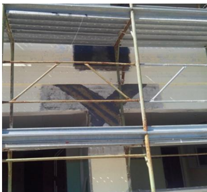
Immagine 4: Rinforzo nodi trave – colonna con CFRP.
