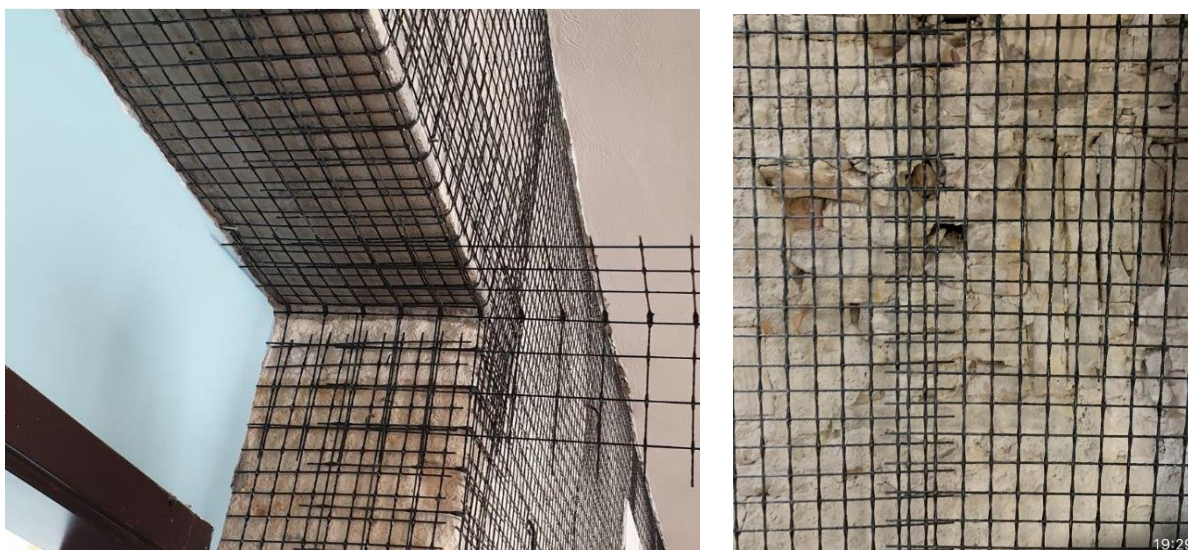
Immagine 3: Rinforzi strutturali con sistema CRM.
