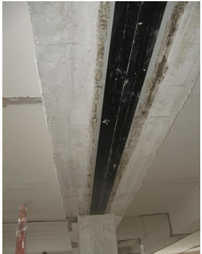
Immagine 1: Rinforzi strutturali con sistema FRP.
