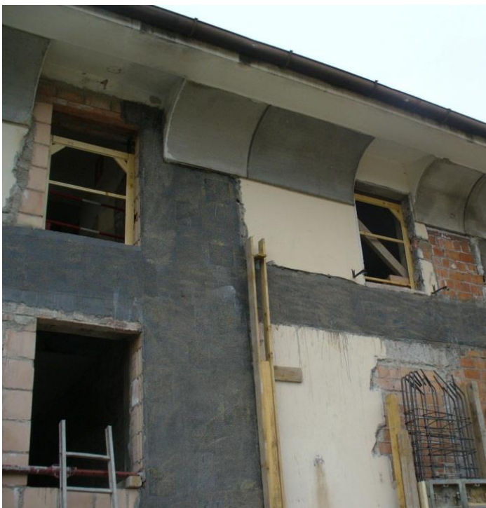
Immagine 18: Fasciatura di piano con CFRP.
