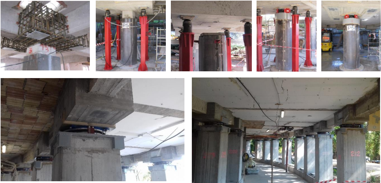
Immagine 31: Procedura d'installazione di isolatore HIRUN HPSLIDE HP2 friction pendulum con intervento di retrofit. Isolatori installati in retrofit per l'adeguamento sismico di clinica privata.
