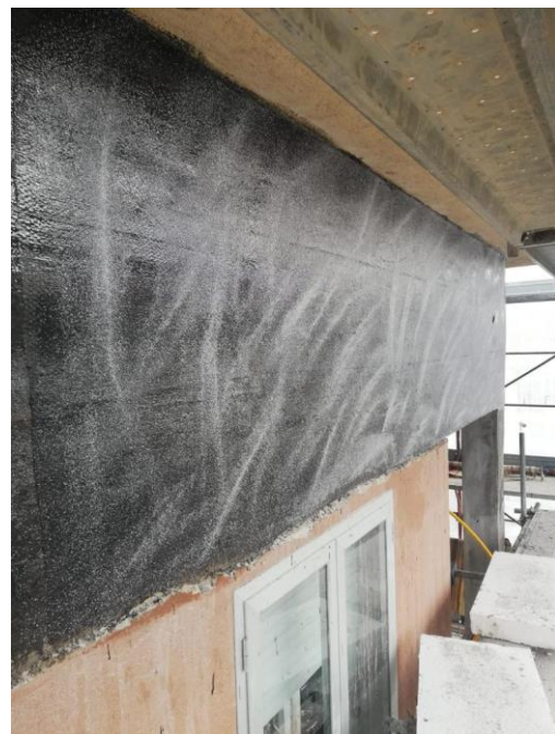
Immagine 7: Rinforzi fasce di piano con CFRP.
