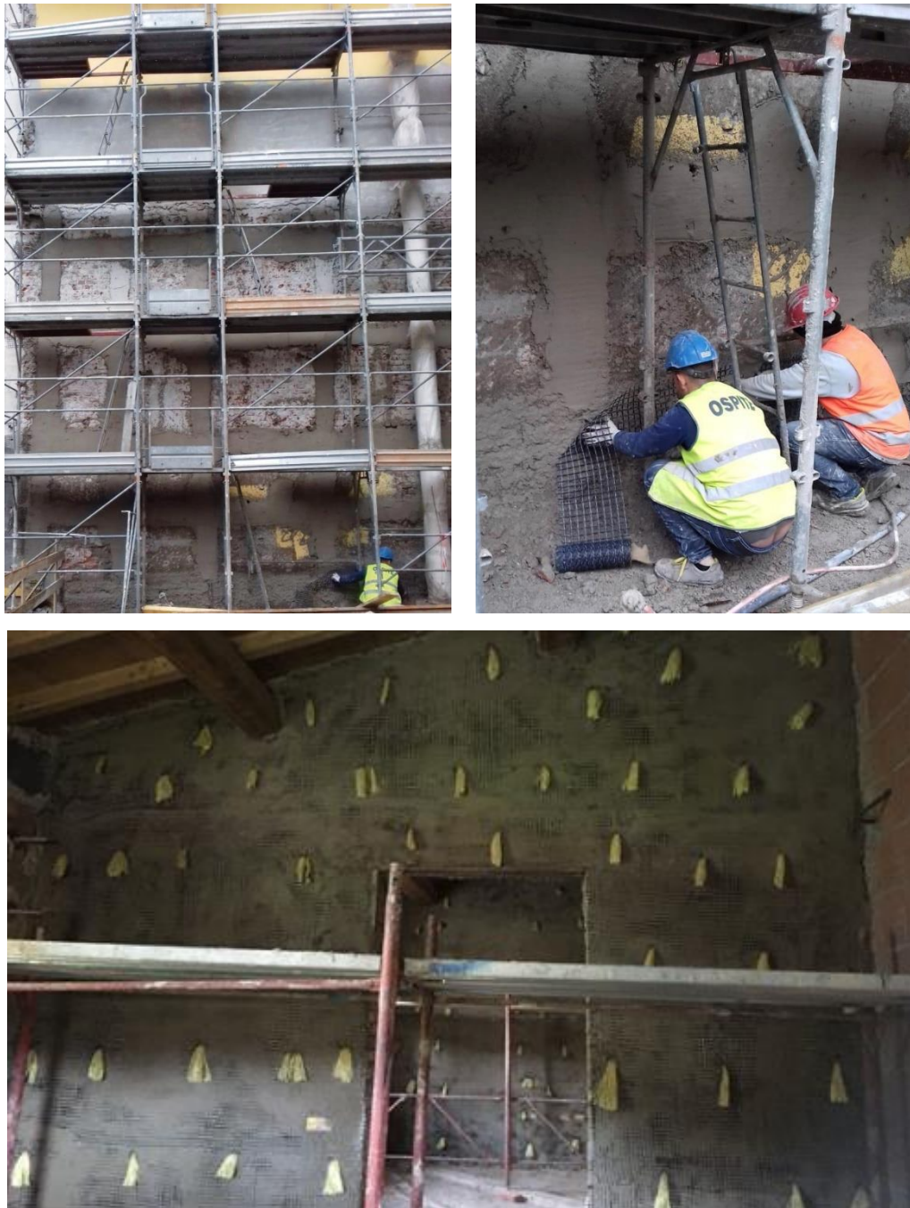
Immagine 2: Rinforzi strutturali con sistema FRCM.
