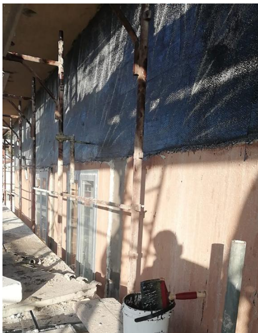
Immagine 7: Rinforzi fasce di piano con CFRP.
