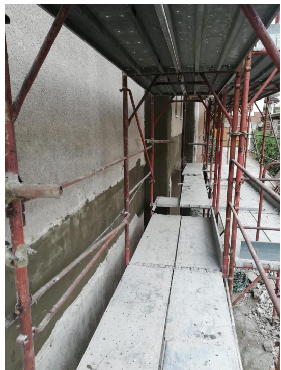
Immagine 18: Fasciatura di piano con CFRP.
