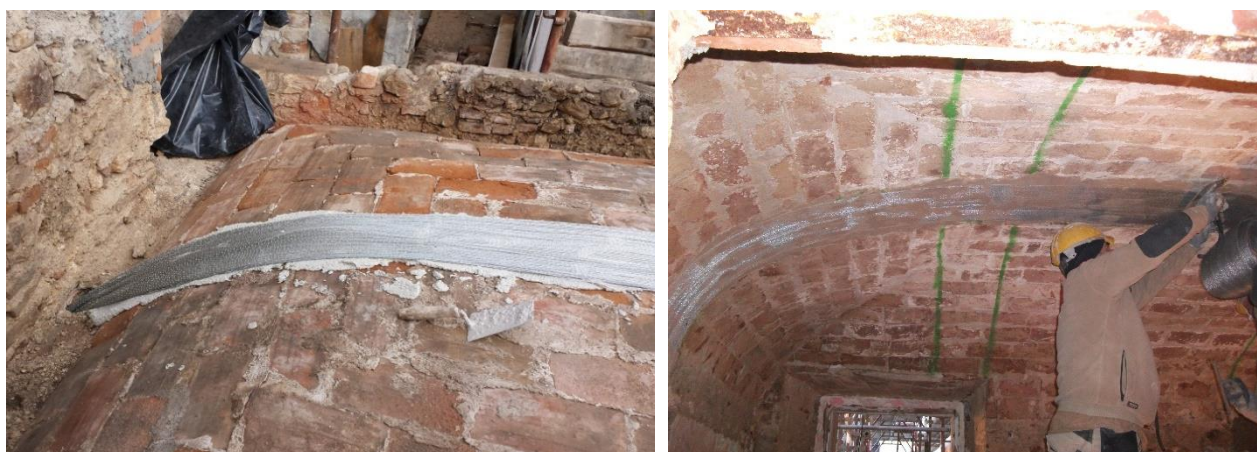
Immagine 28: Rinforzo archi e volte strisce di tessuto SRG.
