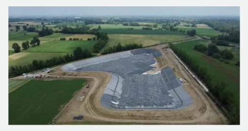
impermeabile in EPDM, scelta dai progettisti per le caratteristiche e i vantaggi di guesto materiale e nello specifico della soluzione GeoGard EPDM di Elevate.
