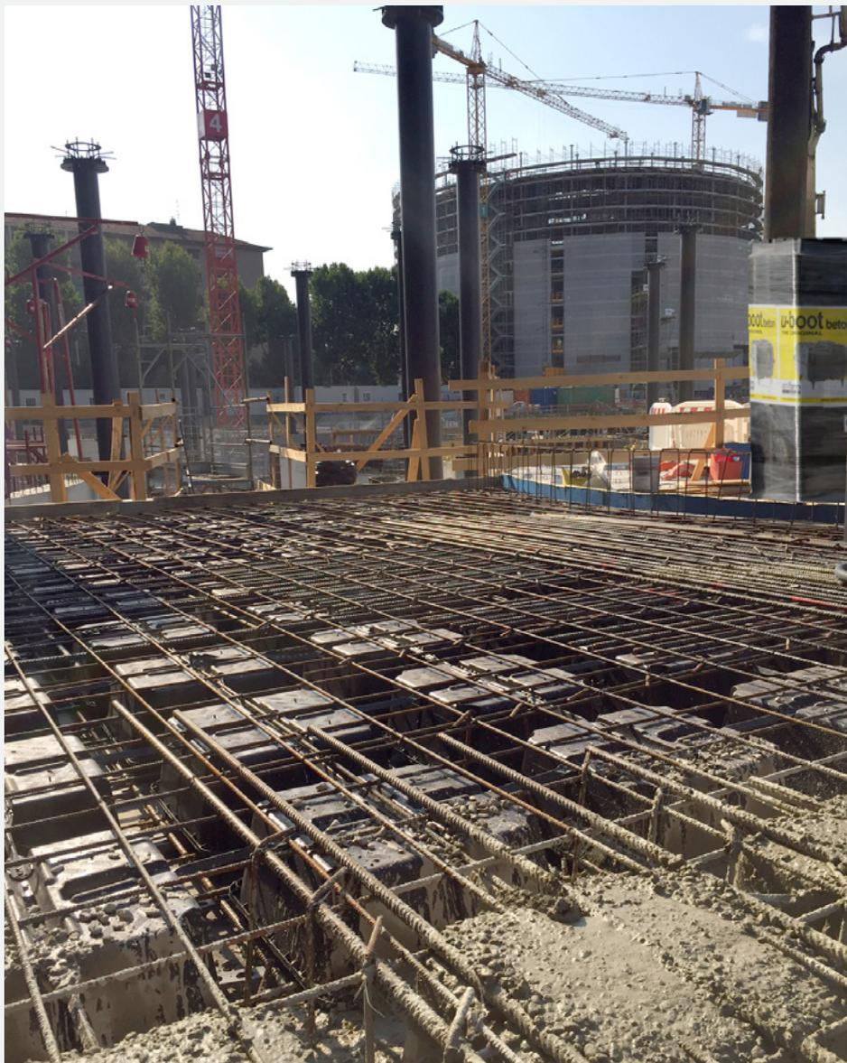
il suo utilizzo si è rivelato, infatti, la soluzione tecnologica ideale per la realizzazione di un'opera che necessitava di piante curvilinee, con irregolarità della disposizione degli elementi portanti verticali e di ampie luci per sfruttare al meglio gli spazi interni. La riduzione del carico complessivo ha permesso, inoltre, un'importante ottimizzazione delle strutture portanti verticali e delle strutture di fondazione.
