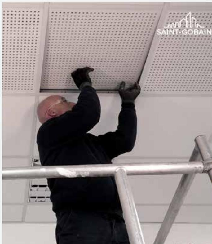
ed Eurocoustic Tonga® A22 nei controsoffitti, e le lastre Gyproc Gyptone® Big Quattro 41 Activ'Air® nelle contropareti. La linea di controsoffitti in gesso rivestito Gyproc Gyptone® è costituita da lastre e pannelli, forati o lisci, ed è pensata per un'ottimale regolazione acustica di ambienti nell'edilizia non residenziale, in particolare aule scolastiche, ma anche uffici, sale conferenze, ristoranti, ecc.
