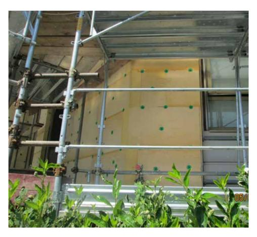
STIFERITE Class SK è un pannello sandwich costituito da un componente isolante in schiuma polyiso, espansa senza l'impiego di CFC o HCFC, rivestito su entrambe le facce con velo vetro saturato.
