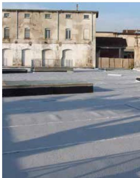
TKone G Drain di TeMa Building Solutions, che è in grado di svolgere allo stesso tempo un'efficace azione sia di protezione meccanica dell'impermeabilizzazione, sia di raccolta e drenaggio molto rapida dell'acqua meteorica verso gli appositi scarichi, sfruttando una pendenza minima necessaria.
