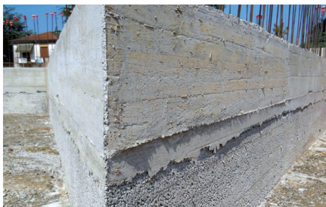
Strato di Leca TermoPiù cementato sotto platea.
