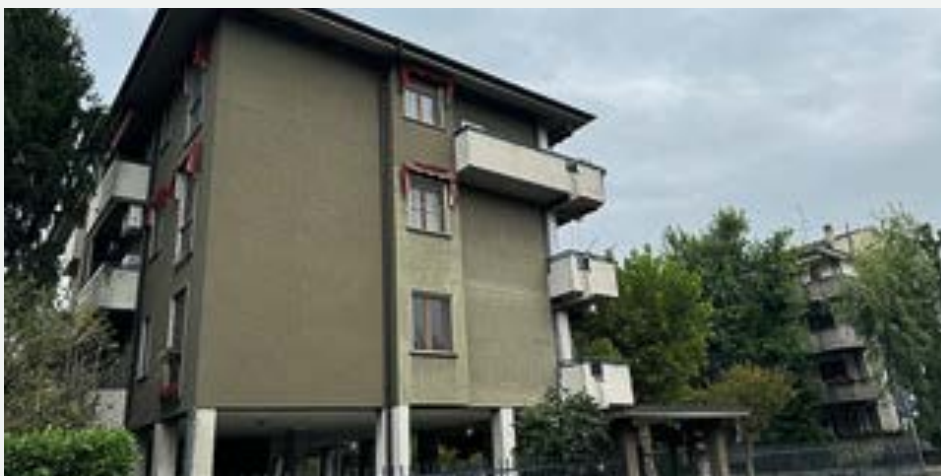
Il condominio anni '70 oggetto dell'intervento, in provincia di Pavia: struttura in c.a. piano terra su pilotis.
