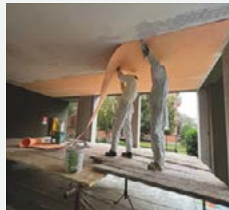
Posa della membrana Isobell sul solaio dell'androne: cantiere rapido e pulito, senza tasselli né demolizioni.
